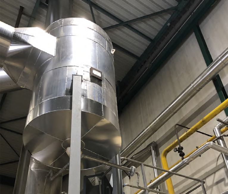
Afbeelding: Voorbeeld warmteterugwinning installatie
